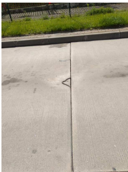
Fot. 8. Szczeliny dylatacyjne wymagające remontu.
