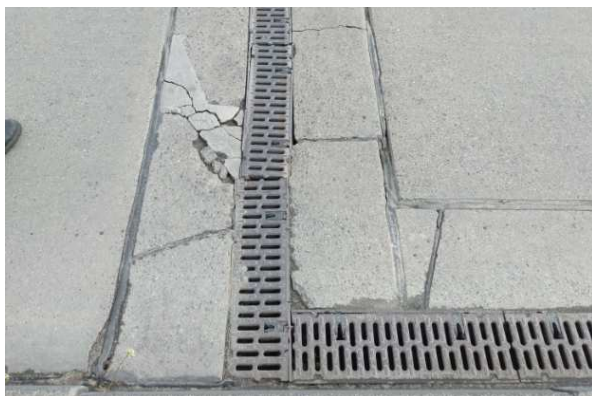
Fot. 7. Odwodnienie liniowe przeznaczone do remontu
