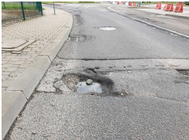
Fot. 2. Uszkodzenia konstrukcji nawierzchni bitumicznej
