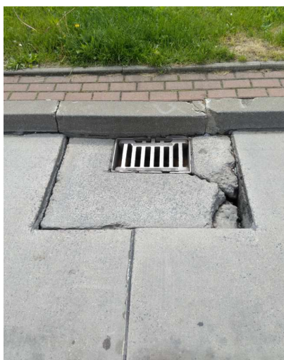
Fot. 6. Wpust uliczny przeznaczony do remontu
