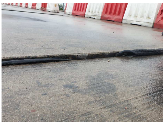
Fot. 4. Nawierzchnia betonowa – uskok poprzeczny na połączeniu płyt
