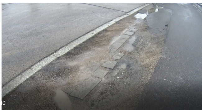
Fot. 3. Uszkodzenia konstrukcji nawierzchni bitumicznej
